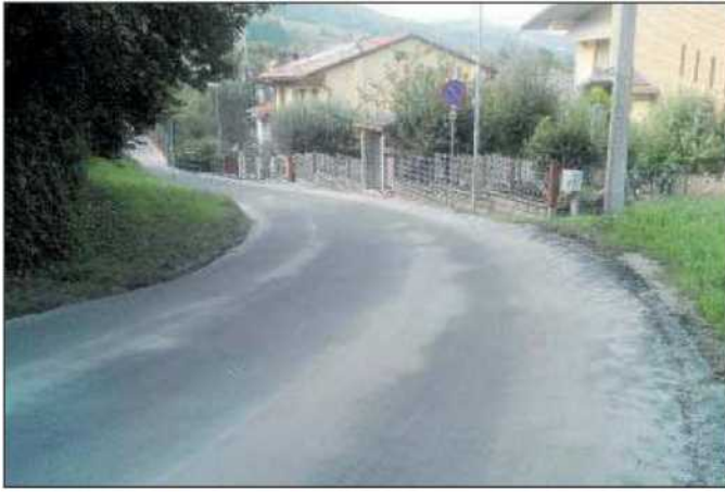
Nuovo asfalto per la via San Demetrio
